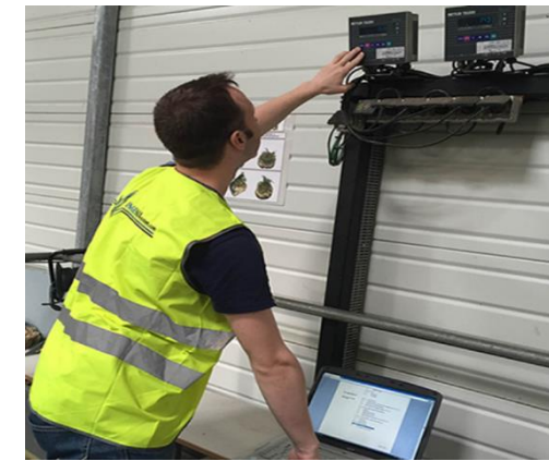
Fig. 2: Un PC dialogue en Ethernet avec le châssis cDAQ chargé de dialoguer via E/S avec un API Siemens et avec les interfaces séries NI ENET-232 pour remonter les différentes pesées vers la supervision.
